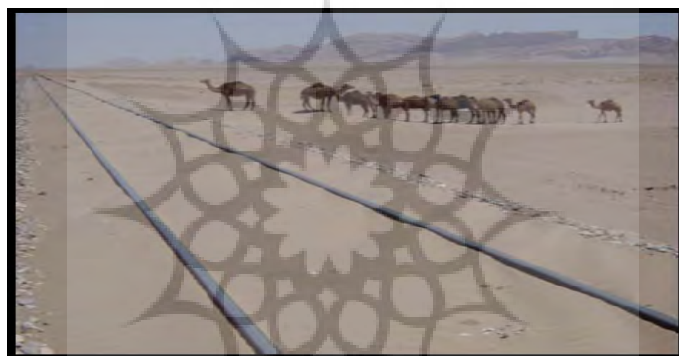
شکل ۸- تصویر مسدود شده راه آهن توسط شن‌های روان
