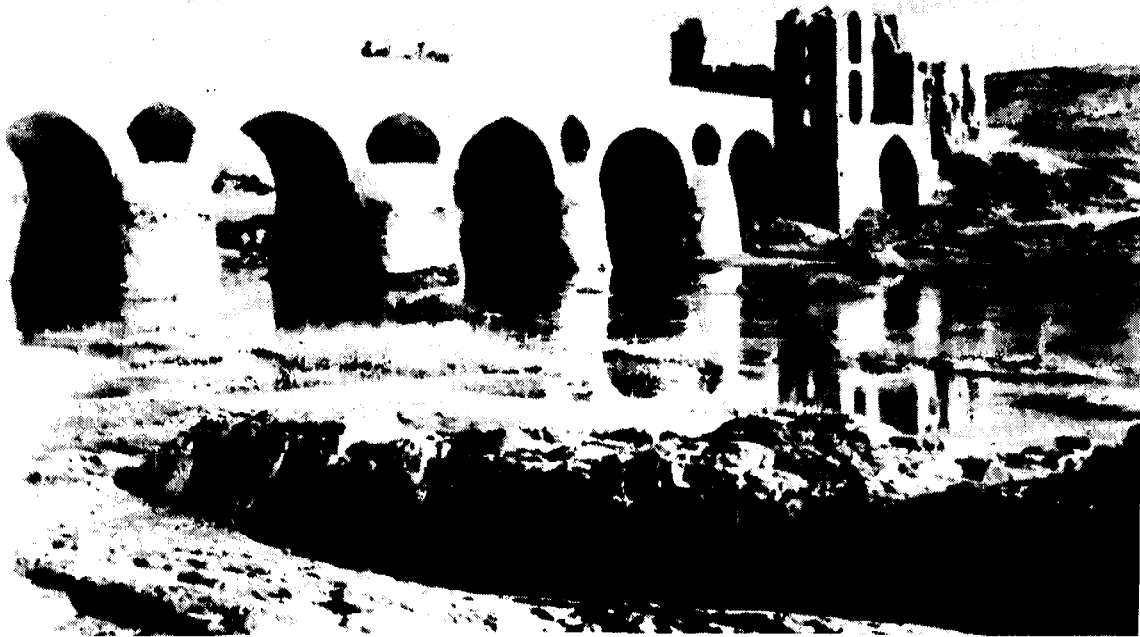
عکس کنونی پل شهرستان - صخره‌های بستر رودخانه در این عکس بخوبی هویدا است
