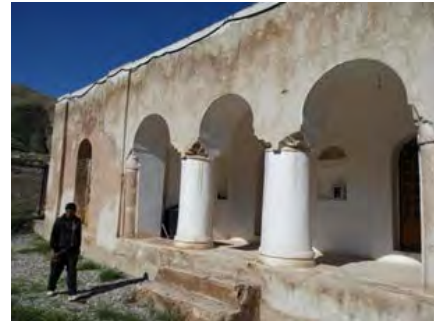
تصاویر ۹. نمایی از ستون‌های درگاه جنوبی و طاق ضربی قلعه جهانگیرآباد (نگارنده).
