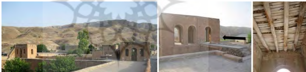
تصاویر ۴. راست: سقف تیرپوش اتاق‌ها - وسط: اتاق سردر بنا میرغلام و مسیر دسترسی به آن - چپ: اتاق‌های ضلع جنوبی (نگارنده).
