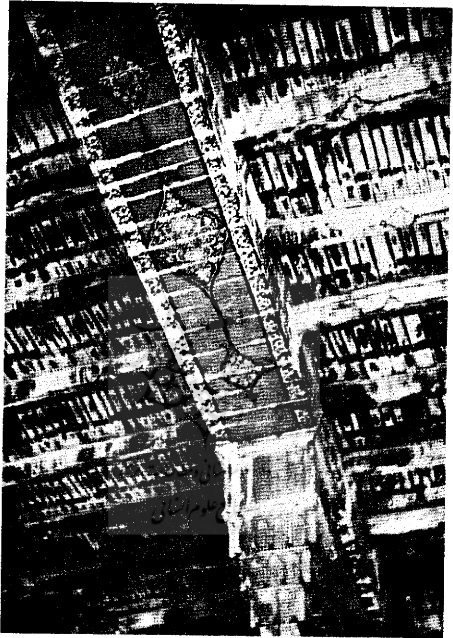
شکل ۵ تصویری از تزئینات نقاشی روی صندوقه چوبی تیرهای جمال سقف - عکس از نگارنده
