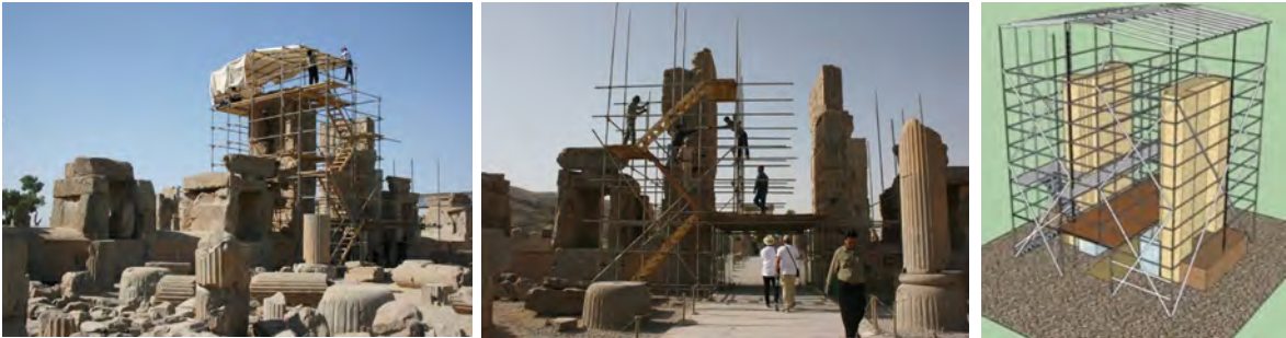
شکل ۱۱. طراحی و برپایی داربست کارگاه، نگارنده
