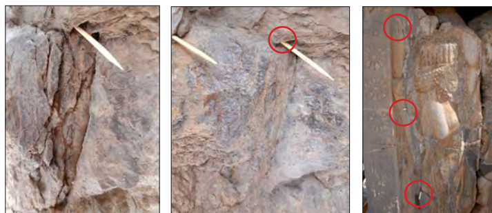
شکل ۱۶. ملاط گذاری و تعیین محل برای تزریق لدان
