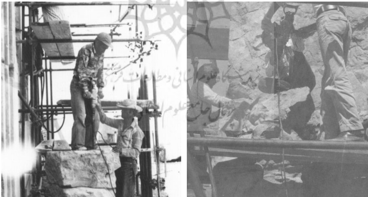
شکل ۶. نمای پشت جزر غربی، در حین تعمیر و نصب سر قطعه وصالی شده، دفتر حفاظت و مرمت، ۱۳۶۰-۱۳۵۸، (عکس: حسن راهساز)
