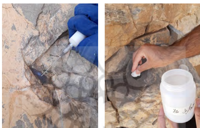
شکل ۱۴. تثبیت بخش‌های ورقه شده با میکرواکریل
