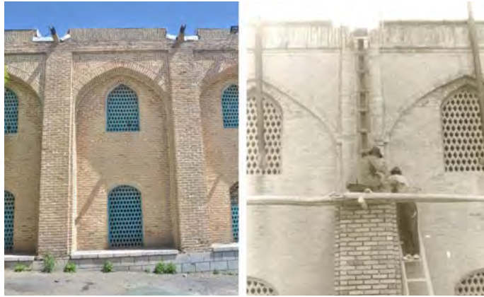
تصویر ۷: راست: ساخت پشت‌بند‌های دیوار غربی شیبستان در دهه سی (اسناد اداره کل میراث فرهنگی کردستان)، چپ: صورت امروزی دیوار غربی شیبستان
