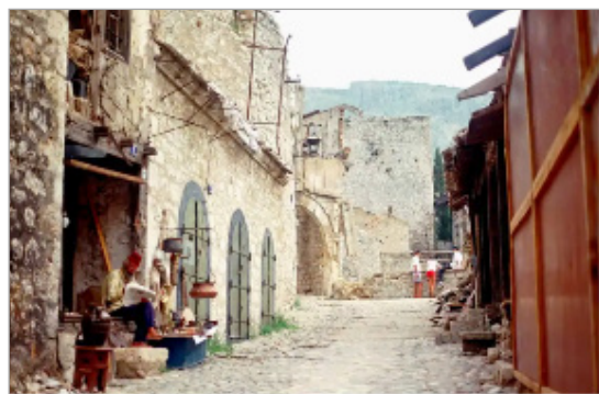
شکل ۱۸: ساختمان های آسیب دیده در بخش قدیمی شهر موستار در ژوئن ۱۹۹۳ (URL7)
