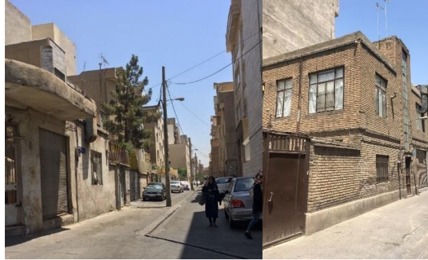
شکل ۴. ساختمان‌های مسکونی منطقه ۱۰ شهر تهران
