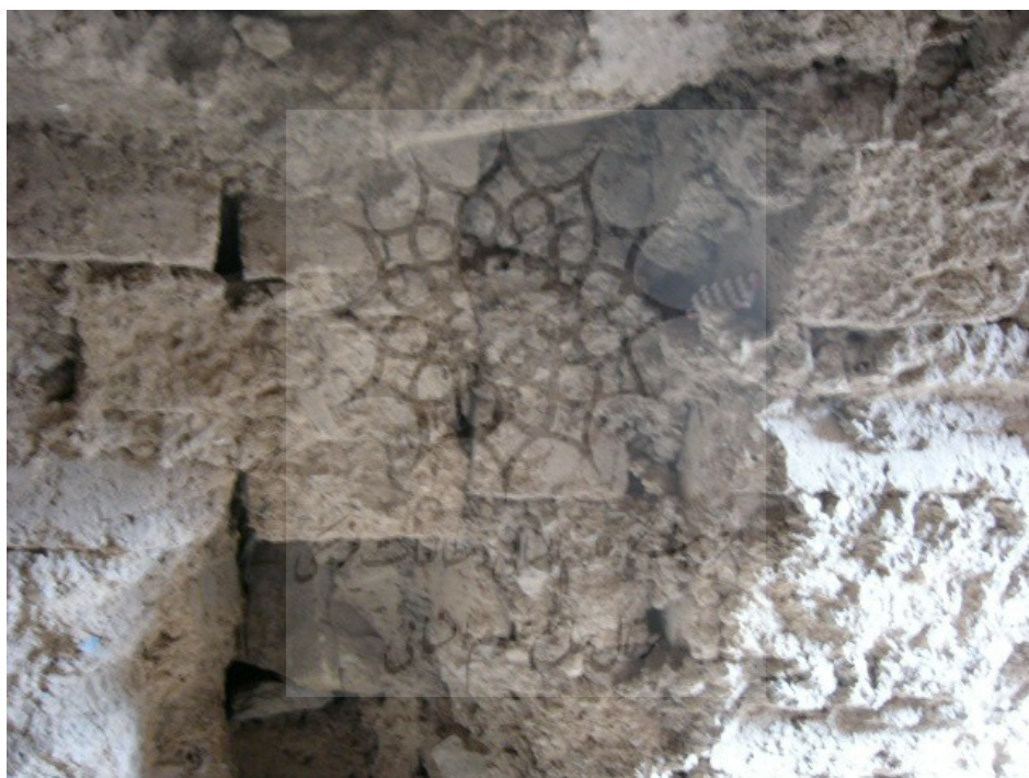
تصویر ۶. نمایی از دیواره سازه خشتی داخل زاغه کنده شده
