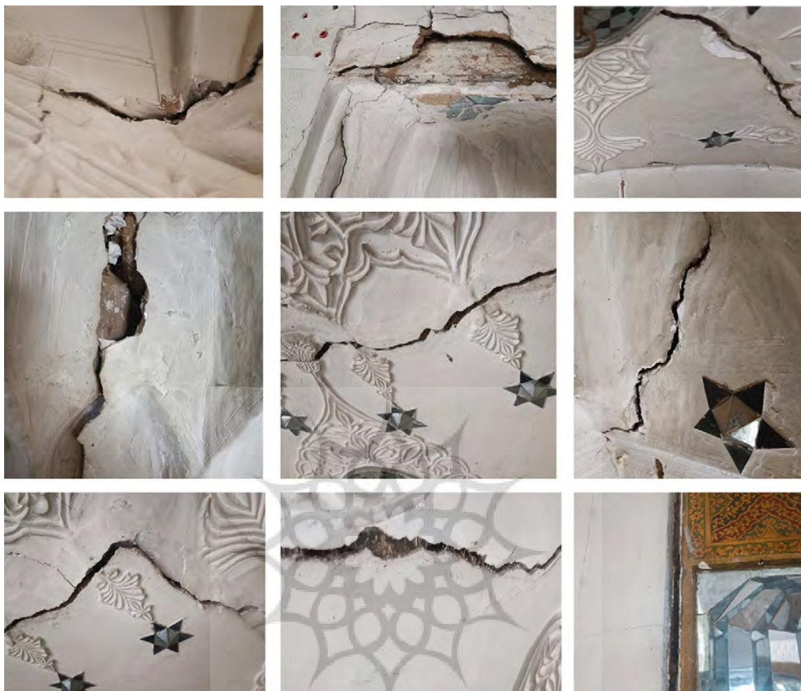
شکل ۶. بخشی از ترک‌های سازه‌های سقف و دیوارها که منجر به جدایش آرایه‌ها از لایه تکیه‌گاه شده‌اند
