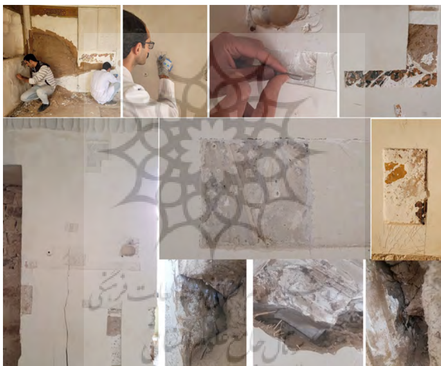
شکل ۹. سونداژ لایه گچ الحاقی و مشخص‌سازی نقوش موجود در زیر لایه‌های اندود
