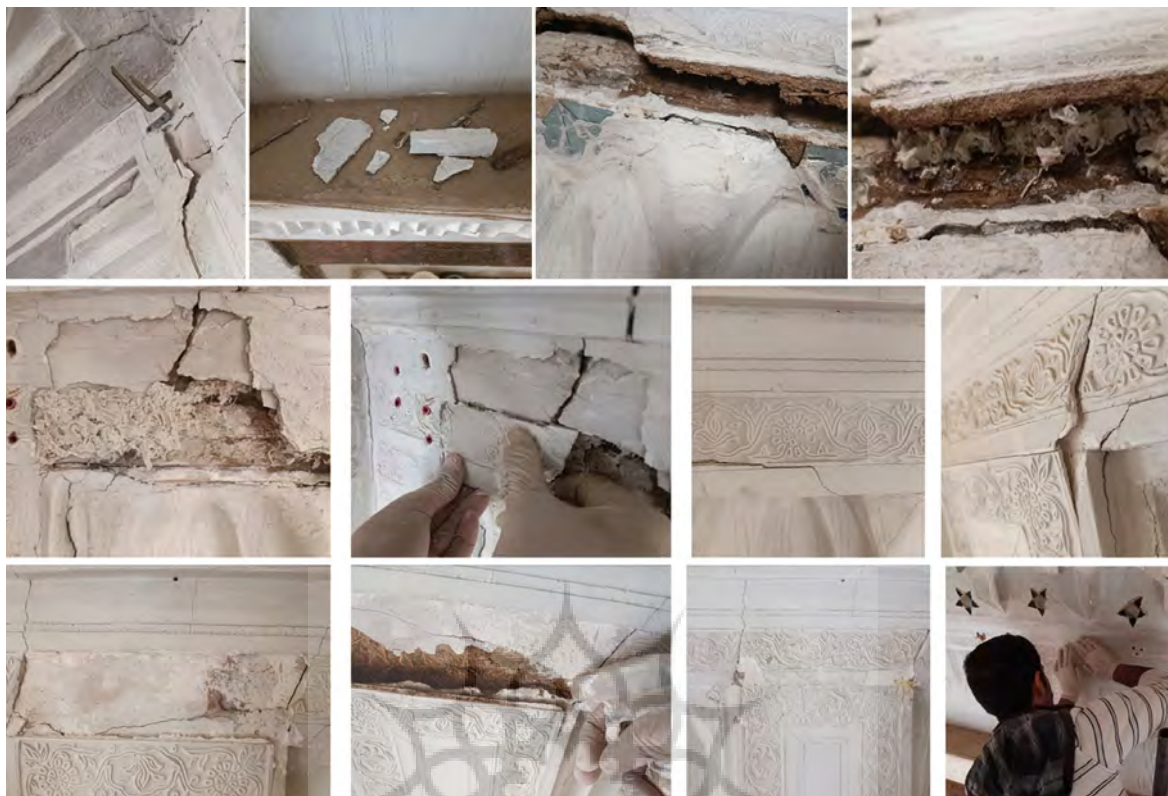
شکل ۱۲. جداسازی، استحکامبخشی و بازگرداندن آرایه‌های گچی قالبی
