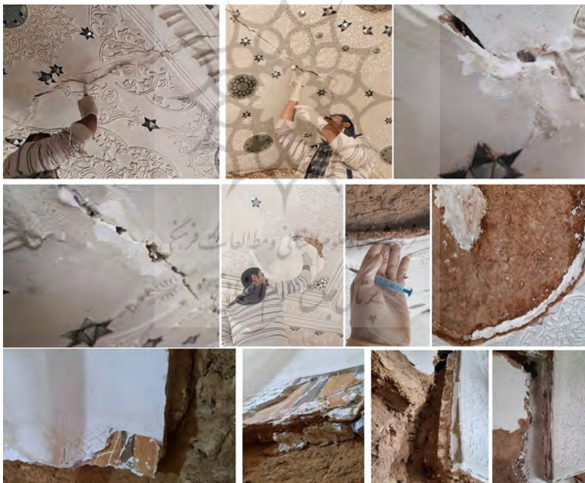
شکل ۱۵. استحکامبخشی آرایه‌های گچی سقف به کمک خمیر گچ و پلکستول رقیق
