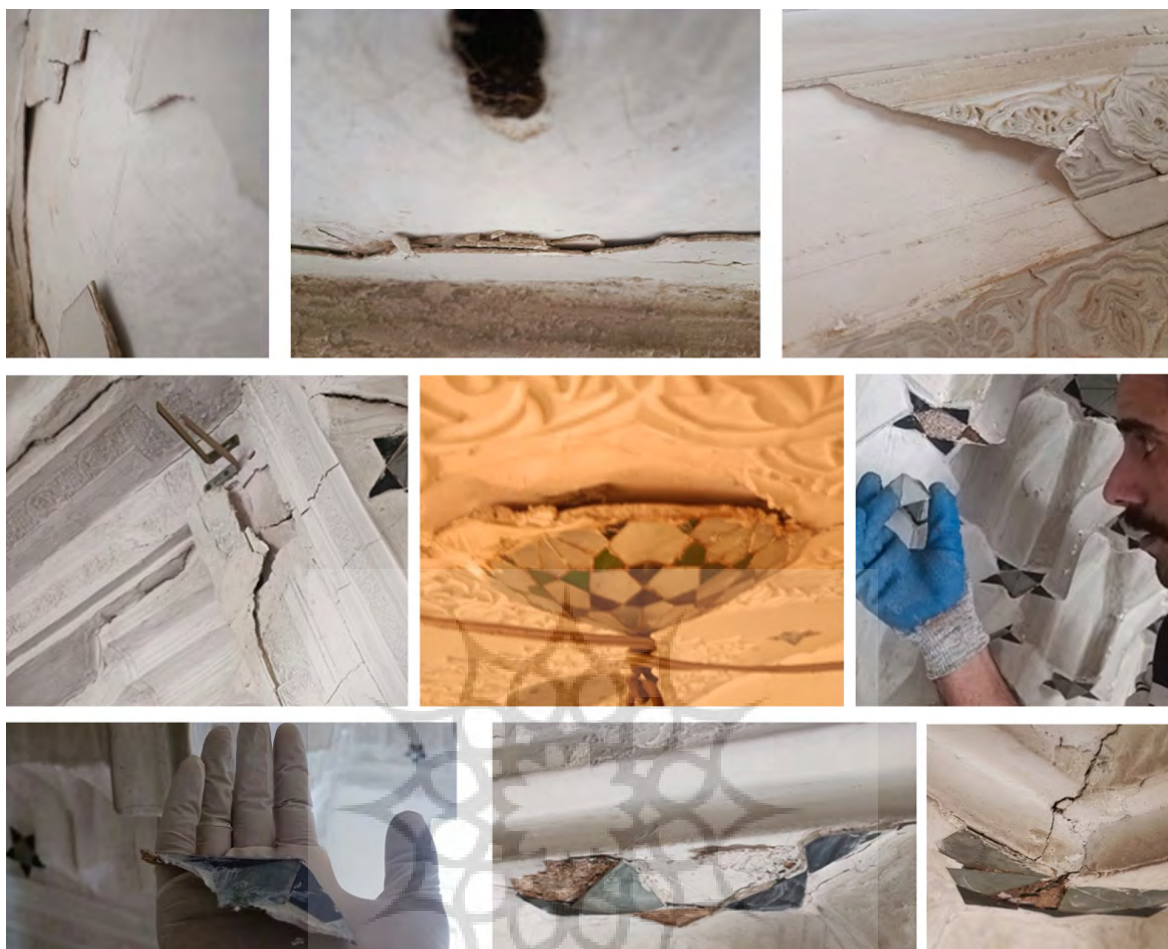
شکل ۷. جدایش آرایه‌های گچی با لایه زیرین خود (لایه بستر زیرین) و سستی اتصال آینه‌ها و شیشه‌ها
