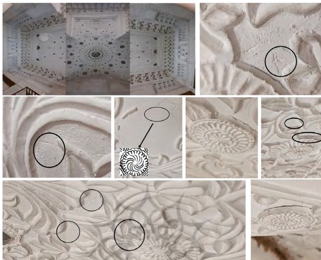
شکل ۴. آرایه های گچی موجود در سقف و همچنین مشخص سازی نوع اجرای نقوش (روش گچبری و روش قالبی)
