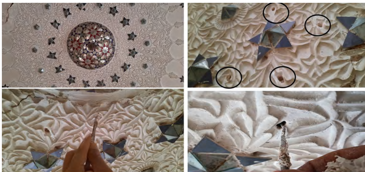
شکل ۱۶. استحکامبخشی و وصل آرایه‌های جدا شده از بخش آستر با ایجاد سونداژهایی در بخش‌های مختلف آرایه‌های بخش مرکزی
