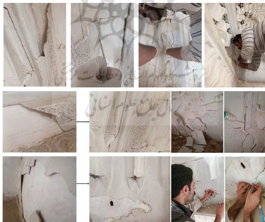
شکل ۱۱. استحکام‌بخشی آرایه‌های جدا شده از لایه زیرین (لایه بستر) خود
