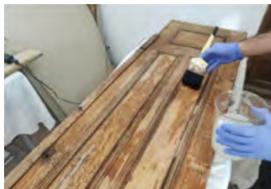
شکل ۲۲. آغشته کردن درب به محلول استحکامبخش
