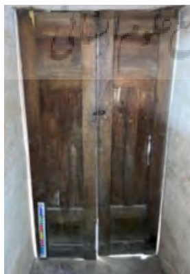
شکل ۵. بخش پشتی در (قبل از مرمت) (راست). شکل ۶. سفت و چفت در بخش پشتی لته‌ها (چپ).
