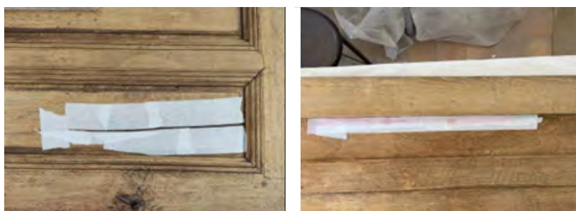
شکل ۲۱. قالب‌گیری بخش ترک‌خورده با استفاده از موم دندان‌پزشکی از بخش پشتی ترک
