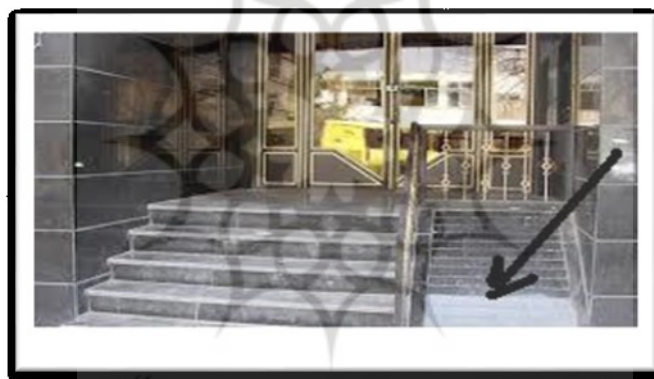
شکل ۵: نمونه عدم اجرای رمپ با شیب استاندارد در ورودی مراکز تجاری
