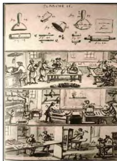
تصویر ۲. طراحی پاپیلون از مراحل تولید کاغذدیواری. ۱. ابزار مورد نیاز در فرآیند چاپ. ۲. مخلوط کردن رنگ، آماده‌سازی ابزار و استفاده از آن روی قالب. ۳. چاپ ورق‌ها، آویزان کردن آن‌ها به منظور خشک‌شدن. ۴. رطوبت‌گیری و مرتب‌کردن کاغذهای چاپ شده. منبع: Wisse, 2005, 17.
