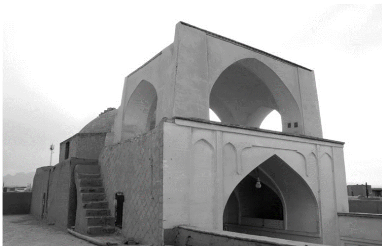
شکل ۳- نمایی از مسجد جامع بفروئیه
