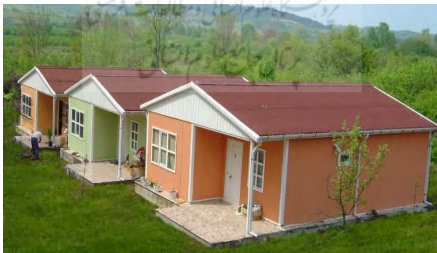
شکل ۲- استفاده از سازه‌های پیش‌ساخته صنعتی در بحران.
