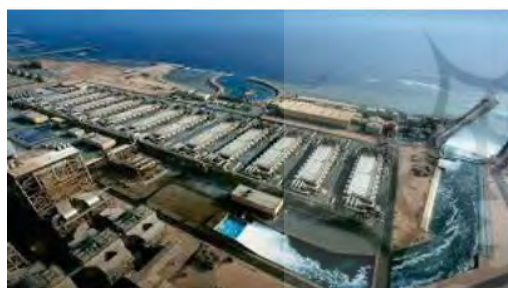
شکل ۴- تاسیسات آب شیرین کنی ایالت گجرات هند (Water Supply Government of Gujarat, 2017).
