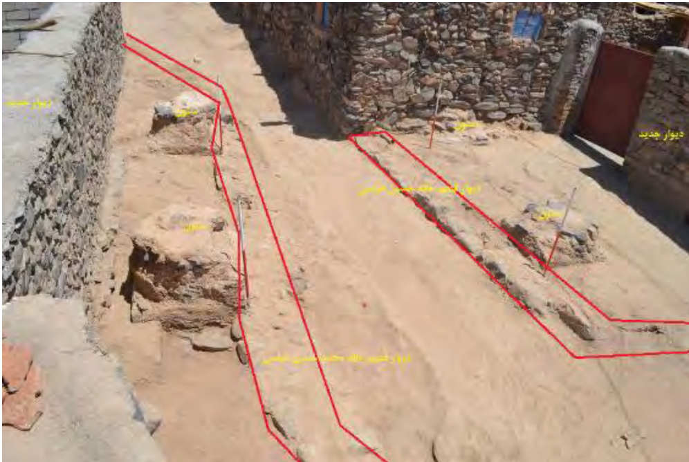
شکل ۷: نمای کلی از آزادسازی ستون‌ها با حذف دیوارهای قدیمی و احداث دیوارهای جدید (نگارندگان).
