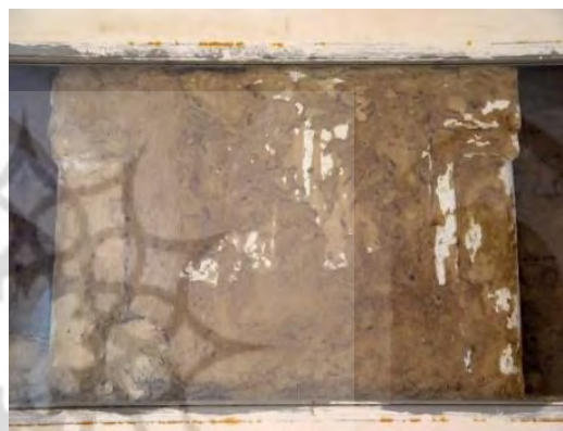
تصویر ۳۴ و ۳۵: بقایای جرزهای مسجد نخستین ابرکوه پس از لایه‌برداری. بر نبش جرزها پیلک کار شده است (عکس راست از نگارنده، چپ از رضا رحمانی).
