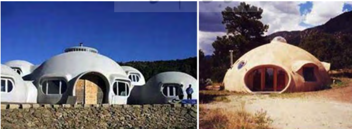
تصویر ۲۸. خانه گنبدی و استفاده از سازه‌های پوسته‌ای؛ ماخذ: تحلیل نگارنده.
