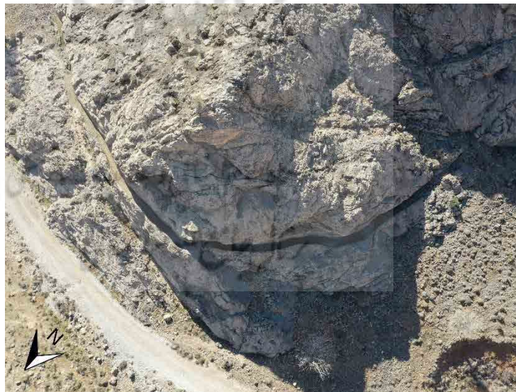
شکل ۲۶. دید هوایی از آبراه دست‌کند کرانه خاوری در دهانه تنگ بلاغی (نگارندگان، ۱۳۹۹). Fig. 26. Aerial view of the east bank's steep waterway in the mouth of Tangbolaghi (Authors, 2019).
