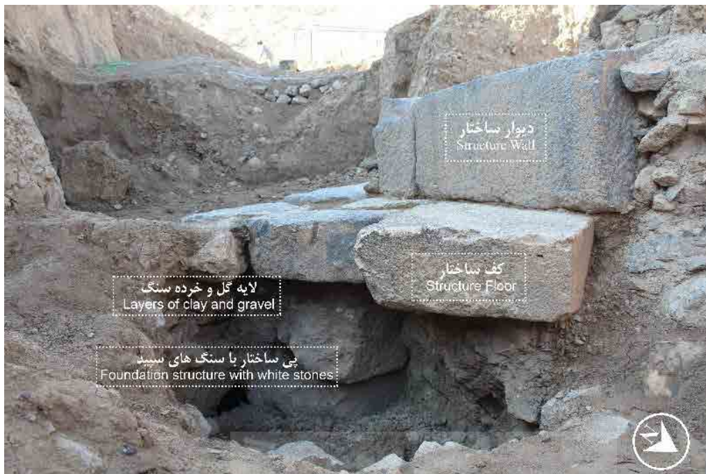
شکل ۳۹. ساختار معماری درون هسته سد دیدگان با روش خشکه‌چینی (کرمی، ۱۳۹۹). Fig. 39. The architectural structure inside the core of Didegan Dam by dry-picking method (Karami, 2019).
