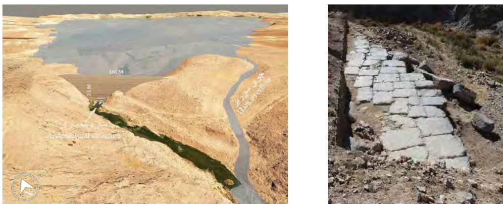
شکل ۷. بقایای کف فرش سنگی برجای مانده از ساختار آب پخش و تنظیم‌کننده‌های خروجی آب (کریمی، ۱۳۹۹). Fig. 7. Remains of the stone carpet floor left from the water distribution structure and water outlet regulators (Karami, 2019).
