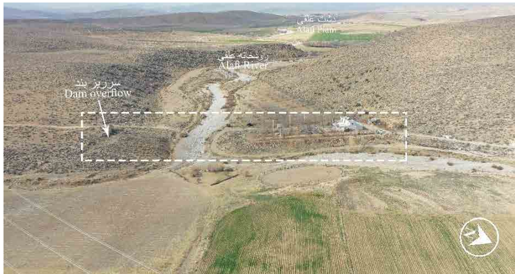
شکل ۱۲. دید هوایی بند شماره دو علفی و ساخت‌وسازهای ایجاد شده روی بخش باختری آن (نگارندگان، ۱۳۹۹). Fig. 12. Aerial view of Dam No. 2 Alafi and the constructions created on its western part (Authors, 2019).
