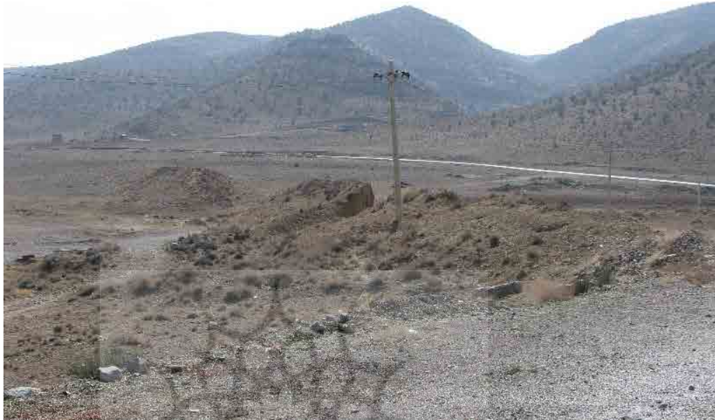
شکل ۱۷. نمای عمومی بند سرپنیران به صورت یک پشته خاکی (کریمی و طالبیان، ۱۳۹۲: ۲۲۹؛ تصویر ۲۸). Fig. 17. General view of Sarpaniran Dam as an earth mound (Karami & Talebian, 2012: 229; Figure 28).
