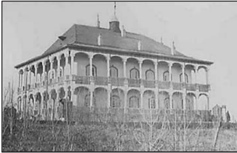
تصویر ۴. قصر یاقوت. اولین بنا در روزگار ناصری بدون نمادها و شاخص‌های معماری ایران، ساختمان این بنا در راستای تجلی فکری در جامعه آن زمان احداث شده است. ماخذ: URL2
