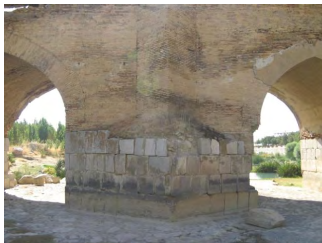
تصویر ۲: نمونه‌ای از آبشکن‌های مثلثی شکل پل بیستون (مرمت‌هایی در دوران اسلامی بر روی آن صورت گرفته است (عکس از نگارنده).
