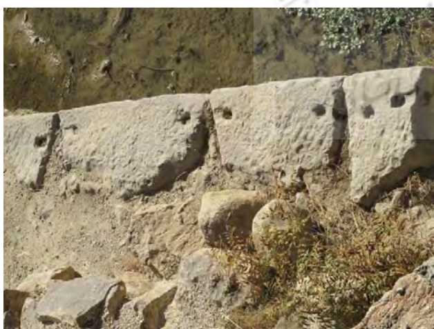
تصویر ۷: نمونه‌ای از بست‌های بکار رفته در پل خسرو (عکس از نگارنده).
