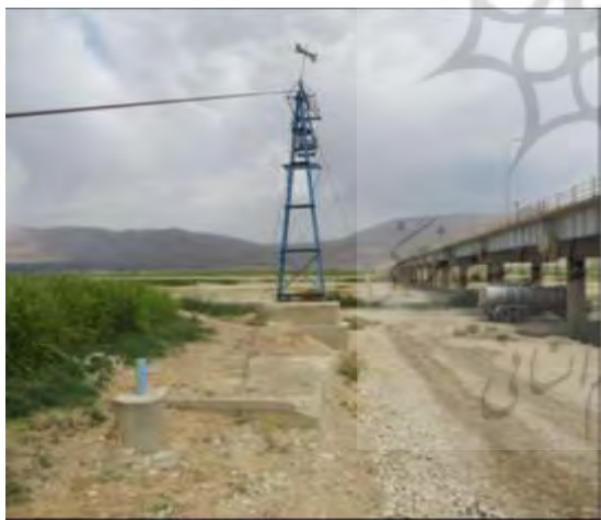
شکل ۲: نمایی از ایستگاه هیدرومتری پل عباس‌آباد به همراه پل تله‌فریک (منبع: تحقیقات نگارندگان ۱۳۹۹)
