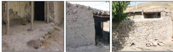
استفاده از قلوه سنگ با ملات گل در دیوارهای بیرونی و تسطیح زمین ایوان
