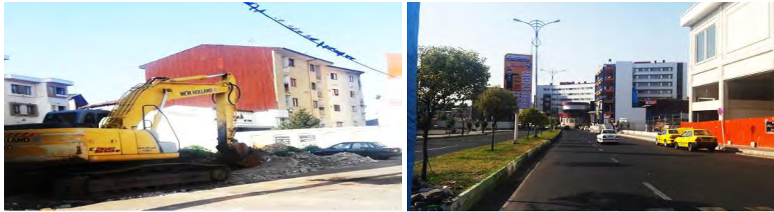
شکل ۱۰. خیابان سرخبنده بعد از بازسازی و ایجاد سازه‌های تجاری-اداری (سمت)، عملیات تخریب بافت‌های فرسوده در طرح محور تختی-صیقلان (سمت چپ)
