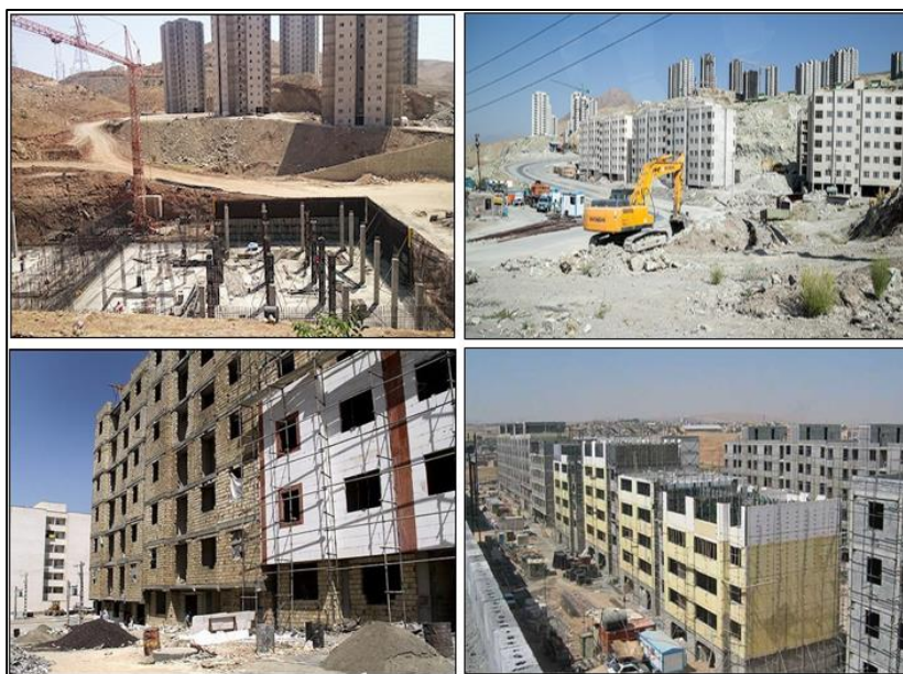
شکل ۵. نمایی از پروژه‌های ساخت مسکن مهر در شهر جدید پردیس
