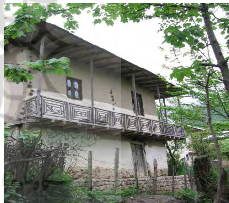
ت 5. تفکیک فضاهای دامی و خدماتی در پایین و فضاهای انسانی در طبقه بالا در روستای سنجیران رودسر.
