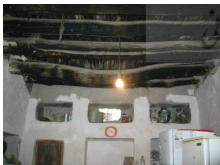
ت 5. دیوار باربر با سقف تیر چوبی.
