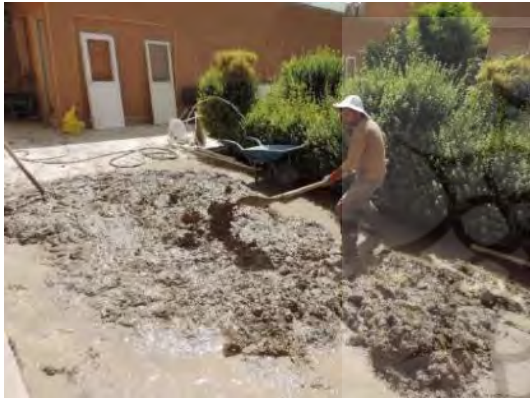
ت ۵. مخلوط کردن و زیر و رو کردن کاهگل قبل از استفاده. مأخذ: نگارنده.
