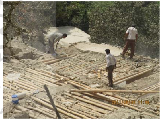
ت ۵. تفکیک مصالح قابل استفاده از مصالح آوار.
