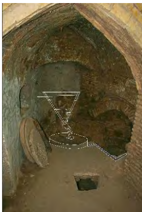
تصویر ۱۱. محل چاله استقرار توربین و حفره جمع شدن آرد در انتهای صحن آسیاب ریگاره منبع: نگارندگان، ۱۳۹۸
