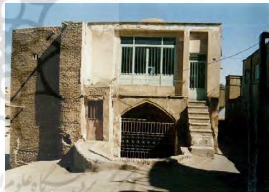
شکل ۱۰. ورودی آب‌انبار در سال ۱۳۸۰
