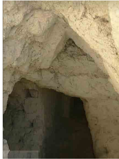
تصویر ۴. اجرای طاق جناغی در یکی از درگاه‌های بنا (نگارندگان، ۱۳۹۷).
