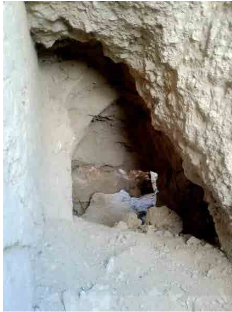
تصویر ۵. شواهد اجرای طاق جناغی از داخل گودال حفاری غیرمجاز (نگارندگان، ۱۳۹۷).
