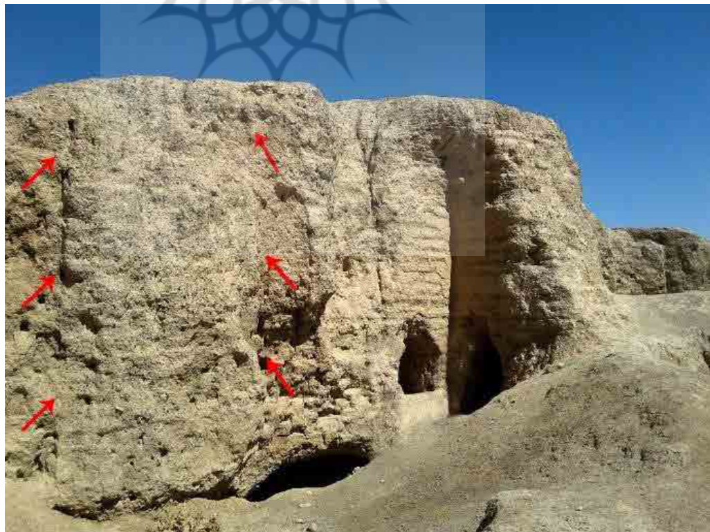
تصویر ۲. پرشدگی بین پشت بند که با علامت قرمز مشخص شده است (نگارندگان، ۱۳۹۷).
