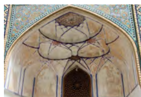
تصویر ۲۱- یک نمونه از یزدی نوع دوم. (۱): آلت سینه فخری. (۲): آلت‌های هندسی خرد شده. تصویر ۲۲- از راست: ۱. ساخت مقرنس به روش ردیف‌های معلق. ۲. یزدی بندی حجره‌های مدرسه چهارباغ اصفهان. ۳. سازه پنهان پشت ردیف‌های معلق. مآخذ: (Galdieri, 1979, 105).
