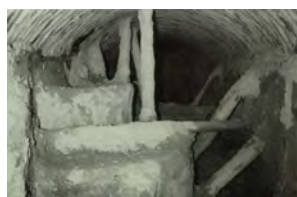
تصویر ۲۱- یک نمونه از یزدی نوع دوم. (۱): آلت سینه فخری. (۲): آلت‌های هندسی خرد شده. تصویر ۲۲- از راست: ۱. ساخت مقرنس به روش ردیف‌های معلق. ۲. یزدی بندی حجره‌های مدرسه چهارباغ اصفهان. ۳. سازه پنهان پشت ردیف‌های معلق. مآخذ: (Galdieri, 1979, 105).
