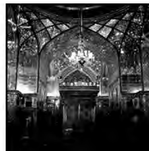
تصویر ۱۱- کاربندی رسمی منفرد نو پا. \{n/d\} = \{20/4\} خانه شماره I۴ ۱۵ نوع زمینه: مربع شامچ رانج، شیراز • ماخذ: گنج نامه جلد ۱۲ •• ماخذ: گنج نامه جلد ۱۲ ••• ترسیم: نگارندگان
