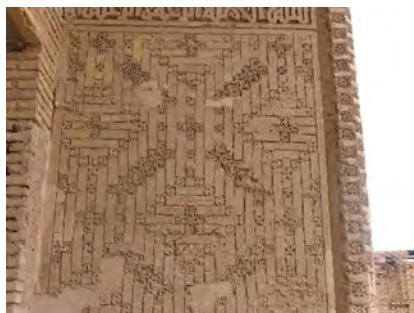
تصویر ۳ و ۴- استفاده از لایه گچ در تمام سطح و شبیه سازی بندهای آجری (مسجد حیاط دوم رباط شرف و راهرو ورودی سردر حیاط اول به دوم).
