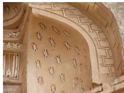
تصویر ۳ و ۴- استفاده از لایه گچ در تمام سطح و شبیه سازی بندهای آجری (مسجد حیاط دوم رباط شرف و راهرو ورودی سردر حیاط اول به دوم).
