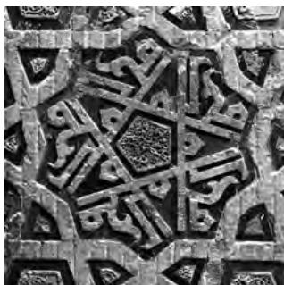
تصویر ۱۶- آجرکاری گنبد سلطانیه در ابرهر، نقش افقی با استفاده از تجربیه هندسه و حروف. ماخذ: ( http://www.aftab.ir/e_card/photo/1796 )
