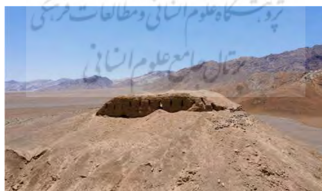
تصویر شماره ۷ - نمایی از دیوار جبهه شمالی بنای باستانی کوه گبری
