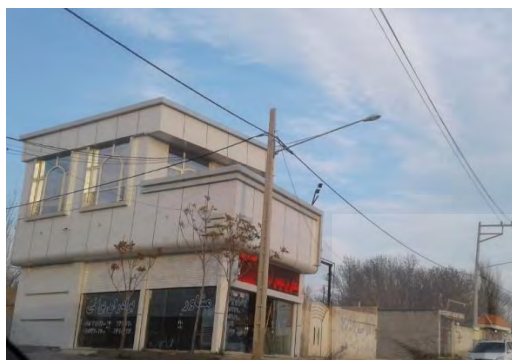
روستای بهار، ۱۳۹۷ (عدم توجه به هویت روستا، ساخت بناهای متمایز از فضای روستا، تغییر شکل و فرم بناها از حالت بومی به نوین (شهری)، ایجاد ساختمان‌هایی با کارکرد جدید و تغییر در کارکردهای مسکن روستایی)
