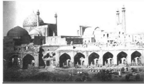
تصویر شماره (۱۳): نمای قدیم کاروانسرا
