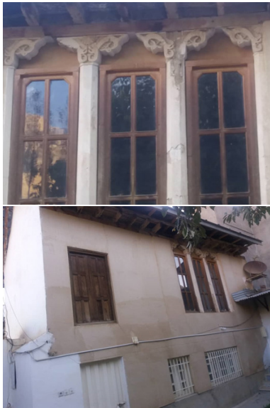
تصویر ۴: الف و ب: پنجره‌های خانه حاج قاسمی همراه با تزئینات گچ‌بری، بنای شمالی جنوبی (نگارندگان، ۱۳۹۸)
