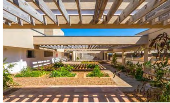
شکل ۹. سازه‌های فلزی با لتهای چوبی (منبع: www.archdaily.com)
