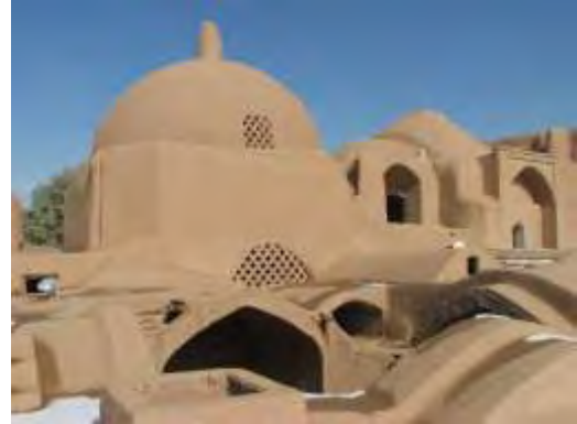
تصویر ۱۰: شنگه و گنبد خشتی خانقاه بندرآباد. ماخذ عکس (نگارندگان)
