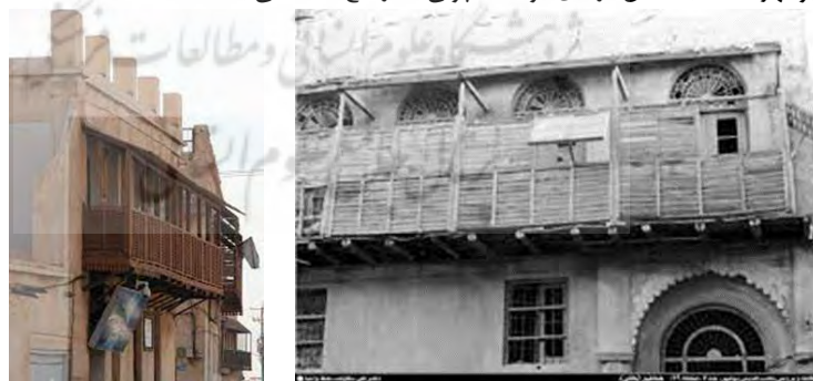
شکل ۲- نمای غربی یک ساختمان در حاشیه ساحل بوشهر، شناسیها باز و بسته (مأخذ: آرشیو مرکز اسناد اداره کل میراث فرهنگی، صنایع دستی و گردشگری استان بوشهر)
