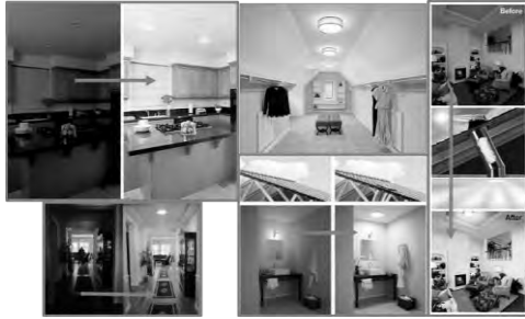
شکل ۱۸- نمونه‌های اجرای لوله نوری
