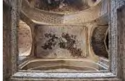
شکل ۴. پوشش خوانچه پوش بر روی چهار تویزه آجری - مسجد جامع قدیم (منبع: نگارندگان)
