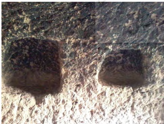
شکل ۷. راست: حفاری توده‌ای برای ایجاد شکل کلی فضا، چپ: حفاری ظریف برای ایجاد طاقچه (نگارندگان، ۱۳۹۹)
