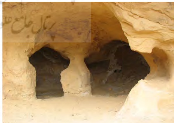
شکل ۷. راست: حفاری توده‌ای برای ایجاد شکل کلی فضا، چپ: حفاری ظریف برای ایجاد طاقچه (نگارندگان، ۱۳۹۹)
