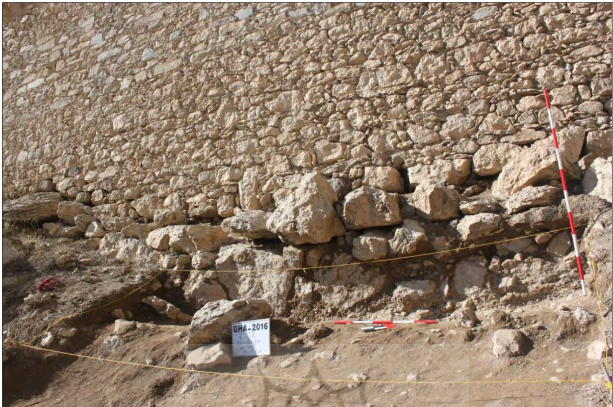
شکل ۲۰. تصویر اجرای دیوار سنگ‌های کوچک‌تر روی سنگ‌های بزرگ‌تر منبع: نگارنده، ۱۳۹۸
