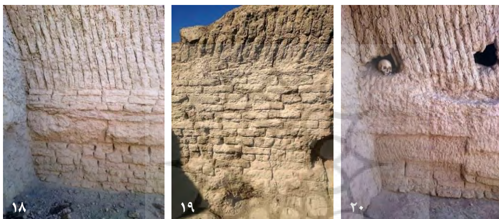
تصویر ۱۸ و ۱۹ و ۲۰: دیوار داخلی آرامگاه از چپ به راست، با سه ترکیب: خشت و چینه و خشت؛ خشت؛ خشت و چینه (مأخذ: نگارنده).
