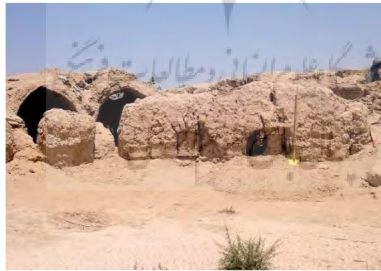
تصویر ۲۷: دیوار جلوی آرامگاه‌ها از داخل حیاط. سرچرزه‌های خشتی مابین آرامگاه‌ها در خرابی‌های دیوار چینه‌ای پیداست (مأخذ: نگارنده).
