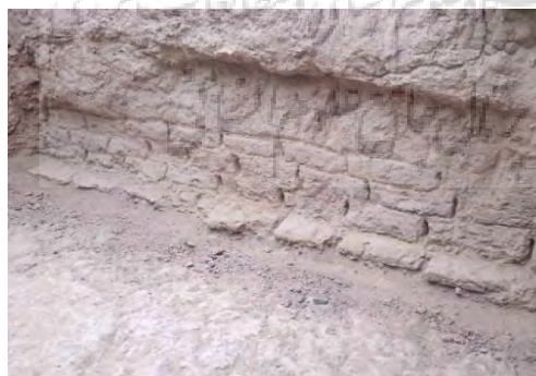
تصویر ۱۵: وضع دیوار داخلی آرامگاه. لایه شن زیر یک ردیف خشت پیش‌داده قرار دارد (مأخذ: نگارنده).
