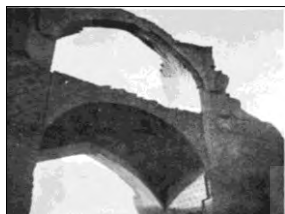
تصویر ۱۵- غرفه غربی مقصوره مسجد هفتشویه، سال گرفتن تصویر ۱۹۶۳ (سیرو، ۱۳۵۷: لوح ۲۴)
