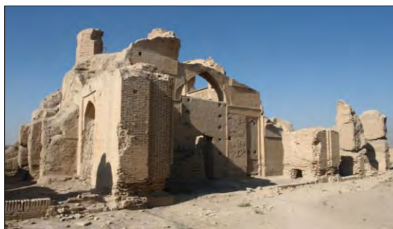
تصویر ۳۵- نمای کلی جبهه جنوبی از داخل حیاط مسجد جامع هفتشویه (نگارندگان، ۱۳۸۵)
