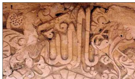
تصویر ۴۹- جزئیات گچبری ضلع غربی گنبد خانه با سوراخ‌های ناشی از کلونی موریانه (نگارندگان، ۱۳۸۵)
